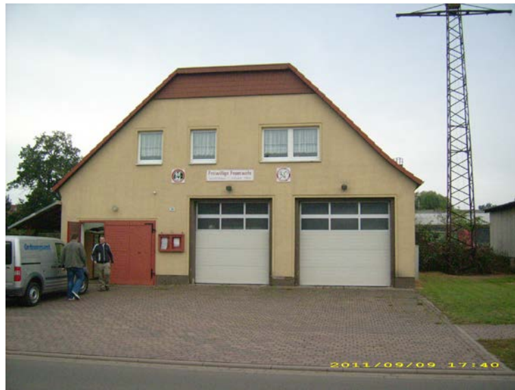
Bild 8 - Ansicht des Feuerwehrhauses Grieben
