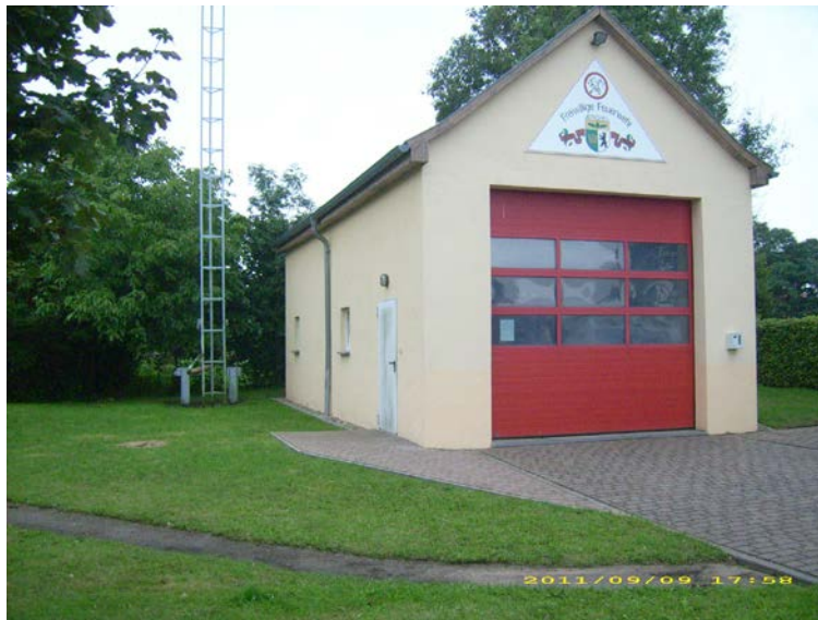
Bild 12 - Ansicht des Feuerwehrgerätehauses Jerchel
