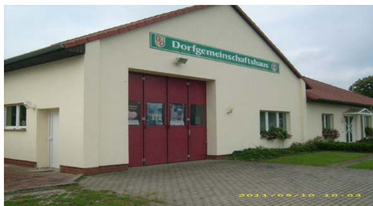
Bild 3 - Feuerwehrstandort im Dorfgemeinschaftshaus
