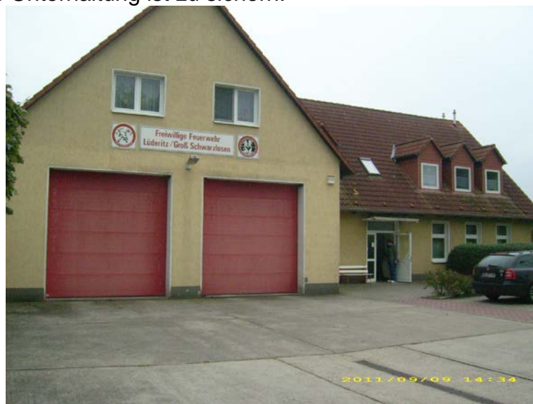
Bild 9 - Ansicht des Feuerwehrhauses Lüderitz / Groß Schwarzlosen
