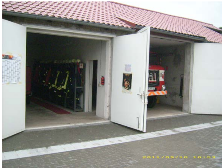
Bild 23 - Blick in das Feuerwehrhaus Uetz
