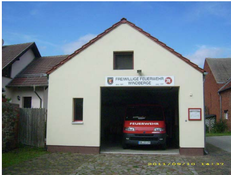
Bild 25 - Ansicht des Feuerwehrhauses Windberge
