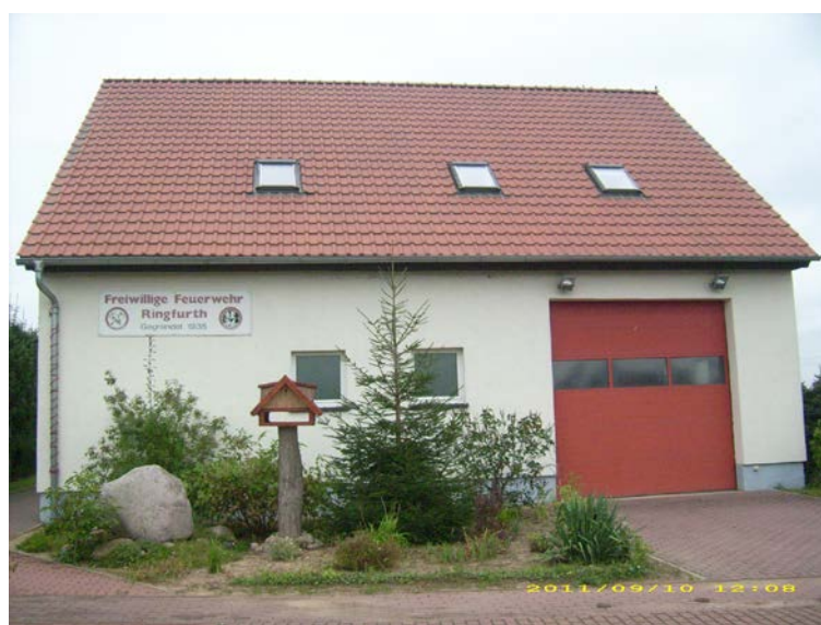
Bild 14 - Ansicht des Feuerwehrhauses Ringfurth
