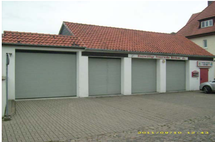
Bild 4 - Ansicht des Feuerwehrhauses Bittkau
