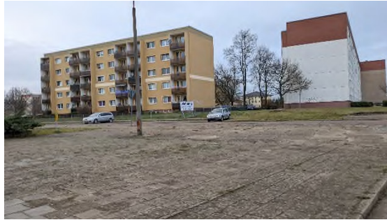
Wohnbebauung nördlich am Neustädter Ring
