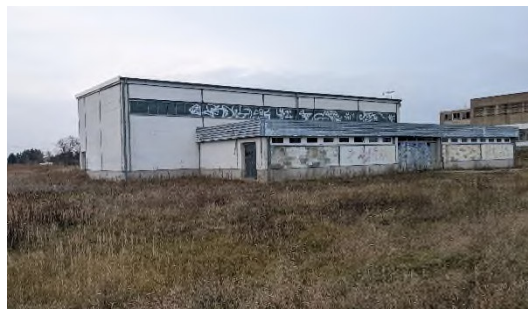
ehem. Turnhalle auf dem Planareal
