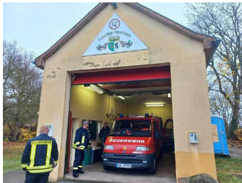
Bild 10 - Ansicht des Feuerwehrgerätehauses Jerchel
