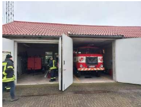
Bild 19 – Blick in das Feuerwehrhaus Uetz
