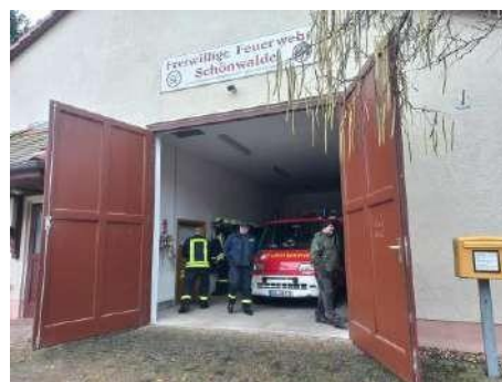
Bild 16 - Ansicht des Feuerwehrhauses Schönwalde
