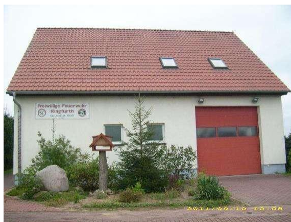
Bild 12 - Ansicht des Feuerwehrhauses Ringfurth
