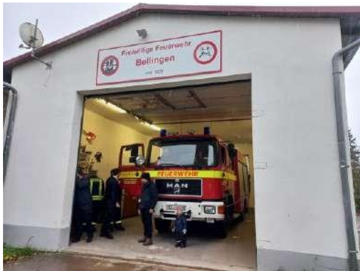
Bild 1 - Ansicht des Feuerwehrstandortes Bellingen
