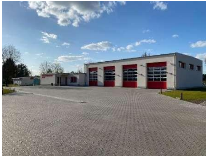
Bild 3 - Ansicht des Feuerwehrhauses Bittkau
