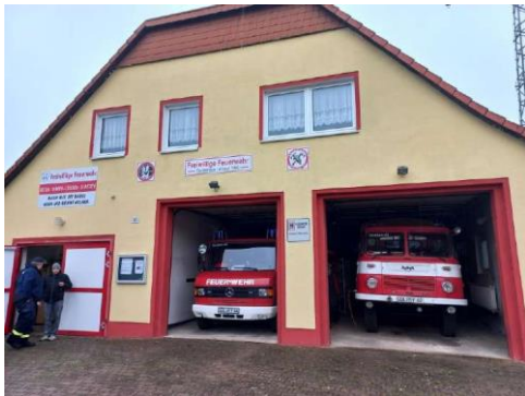
Bild 7 - Ansicht des Feuerwehrhauses Grieben
