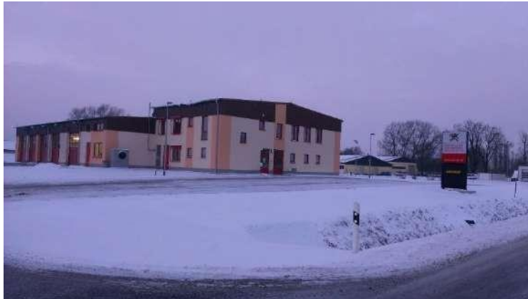
Bild 17 - Ansicht des Feuerwehrhauses Tangerhütte
