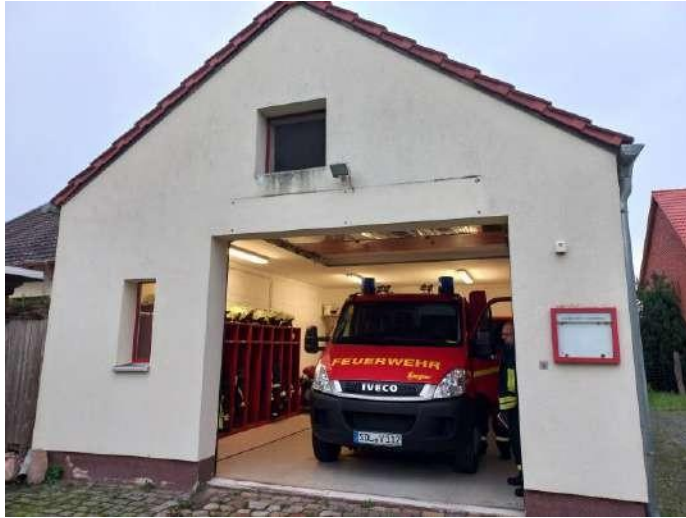
Bild 22 - Ansicht des Feuerwehrhauses Windberge
