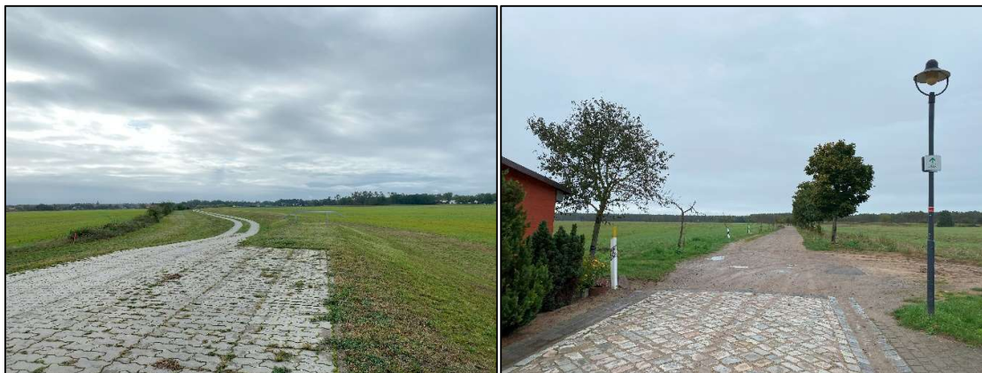
Abbildung 7: links: Blick in Richtung Süden auf den Deichverteidigungsweg sowie die landseitig befindliche Strauch-Baumhecke; rechts: Blick in Richtung Norden vom Ende der Sandstraße in der der Ortslage Weißewarte, im Hintergrund ist die etwa 100 m nördlich gelegene Ackerfläche des Geltungsbereiches sichtbar (M. STILLER, 12.10.2023)
