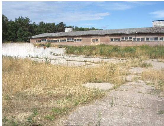
Östliche Vorfläche der Fahrsiloanlage
