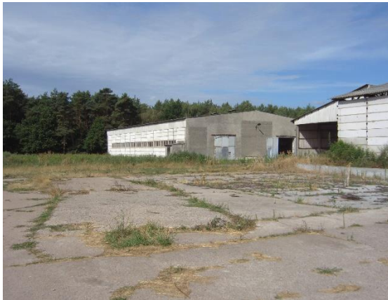
Versiegelter Platz an der nördlichen Grenze des Geltungsbereichs
