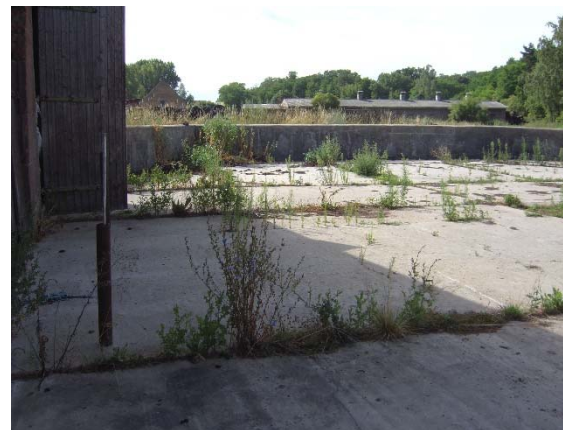
Versiegelte Fläche westlich Stallgebäude und Fahrsiloanlage
