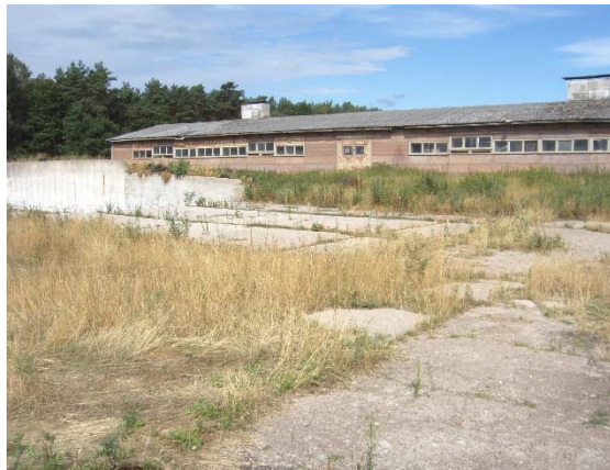
Östliche Vorfläche der Fahrsiloanlage
