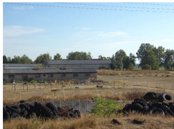
Mittlerer Bereich mit Fahrsiloanlage
