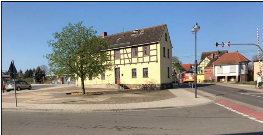
Abb. 6: historisches Gebäude auf dem Flurstück 244/6, Flur 6, Gemarkung Tangerhütte
