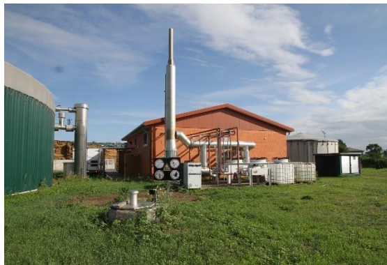
Ruderalflur und Technikgebäude mit Nebenanlagen
