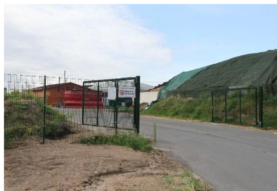
Einfahrt der Biogasanlage
