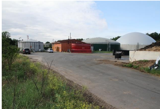
Bauliche Anlagen der Biogasanlage
