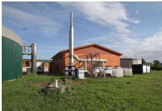
Ruderalflur und Technikgebäude mit Nebenanlagen
