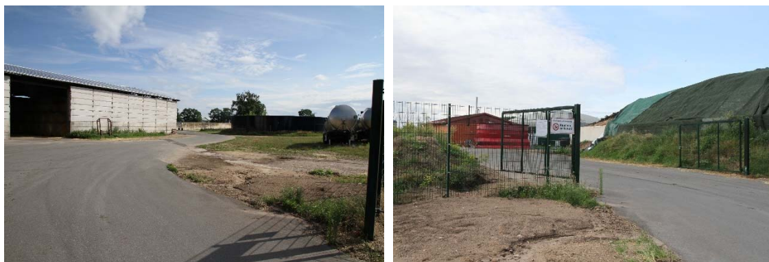
Zufahrt zur Biogasanlage (Wirtschaftsweg) Einfahrt der Biogasanlage
