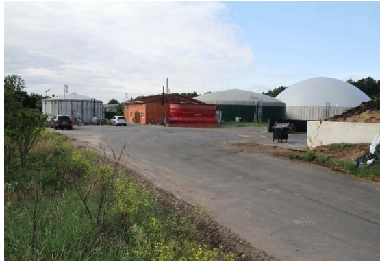
Bauliche Anlagen der Biogasanlage
