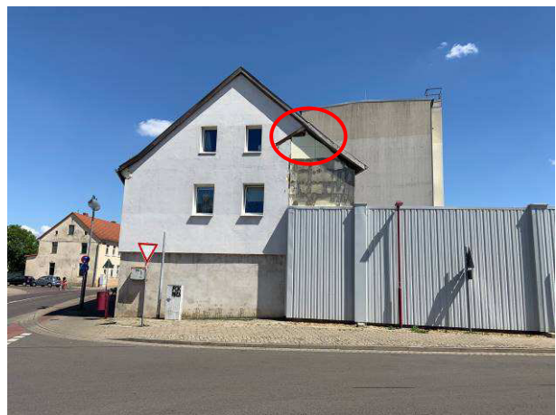
Giebelseite mit möglicher Öffnung für Fledermäuse zum Dachboden
