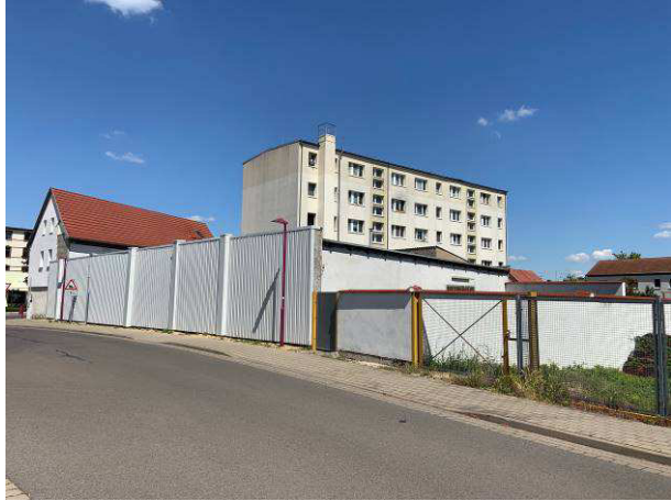
Ansicht nach Nordost; gesamtes Areal des Abrisses
