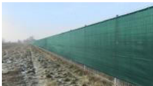
Abbildung 12: Beispiel von Sichtschutzblenden am Anlagenzaun - Quelle: accura-fachhandel.de
